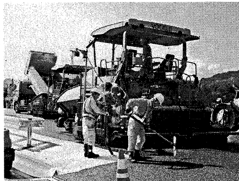
情報化施工で転圧を管理しながら進むアスファルト舗装
