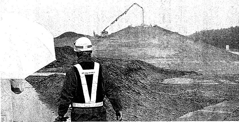
浜松篠原海岸津波対策施設等整備事業(海岸)工事(試験施工1)
