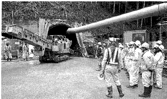
東栄工区の現場見学会(施工＝西松建設)
