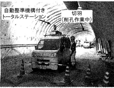
発破掘削方式の道路トンネル（全長約500m、R250区間含む）で壁面変位計測に実適用した結果、TSの
