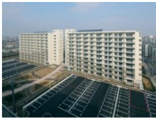
公営住宅整備事業(愛知県名古屋市)
