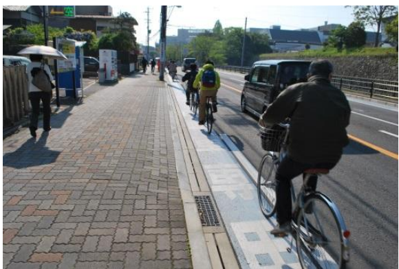
静岡環状線(静岡県静岡市)
