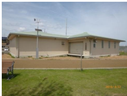
防災倉庫(静岡県焼津市 石津西公園)
