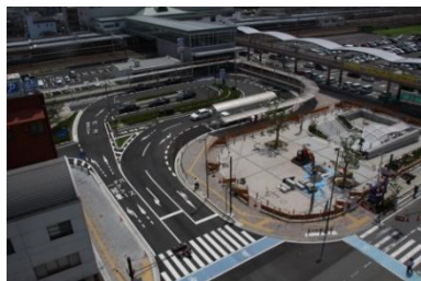
大垣駅北口線(岐阜県大垣市)
