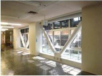
市役所の耐震改修 (岐阜県中津川市)
