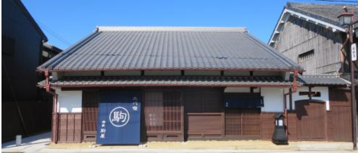
建物全景(改修後)
