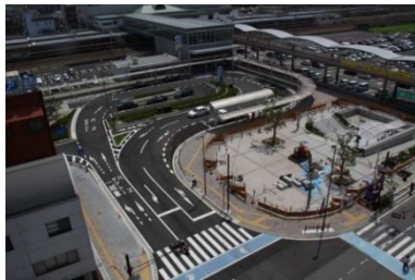
大垣駅北口線(岐阜県大垣市)
