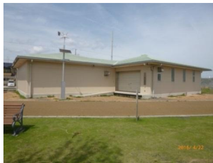
防災倉庫(静岡県焼津市 石津西公園)
