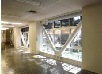
市役所の耐震改修 (岐阜県中津川市)
