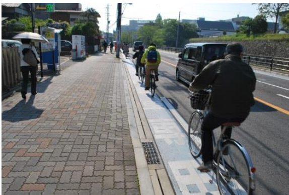
静岡環状線(静岡県静岡市)
