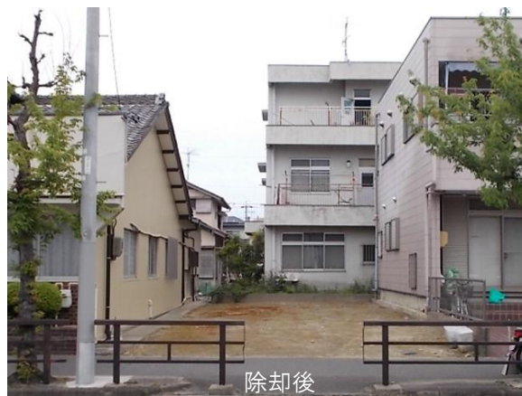
不良住宅の除却 (愛知県一宮市)
