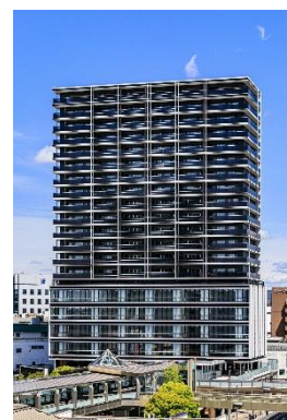
刈谷駅北地区 優良建築物等整備事業 （愛知県刈谷市）
