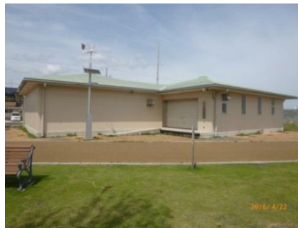
防災倉庫(静岡県焼津市 石津西公園)
