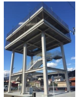
津波避難タワーの整備 (三重県紀北町)
