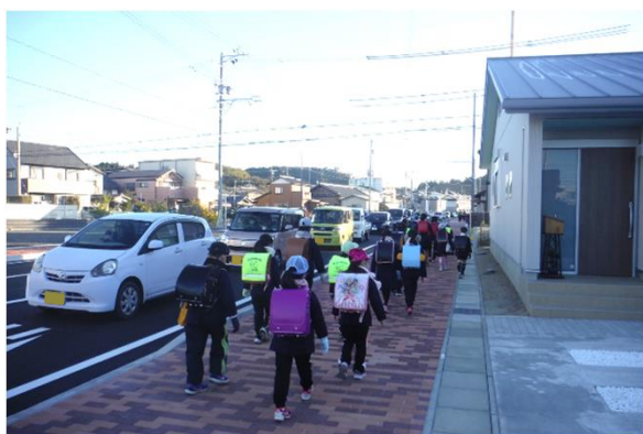
山梨中道通り線(静岡県袋井市)
