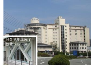
耐震改修事業 (三重県鳥羽市)
