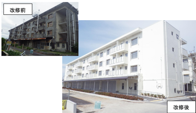
外壁・屋上修繕、耐震改修、居住改善 (静岡県静岡市)
