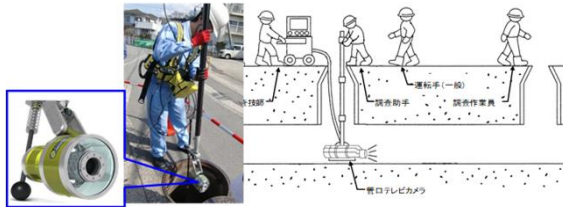
計画的な点検・調査のイメージ（テレビカメラ調査）
