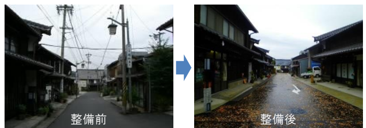
住宅等の修景、道路の美装化 (岐阜県中津川市)
