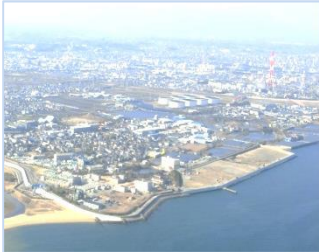
三重県南部浄化センター
