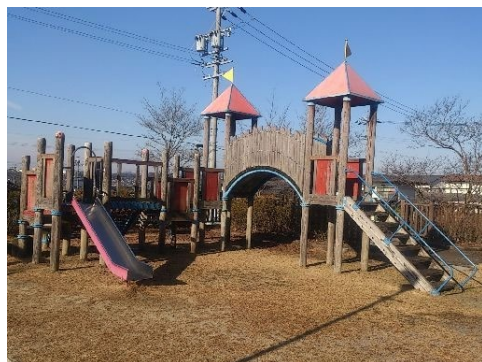
長寿命化計画に基づく遊具の更新 姫白山公園(岐阜県多治見市)
