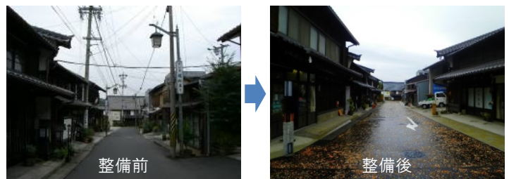
住宅等の修景、道路的美装化 (岐阜県中津川市)
