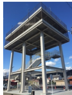
津波避難タワーの整備 (三重県紀北町)
