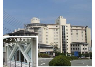
耐震改修事業 (三重県鳥羽市)
