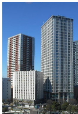
旭・板屋A-2地区 第一種市街地再開発事業 （静岡県浜松市）
