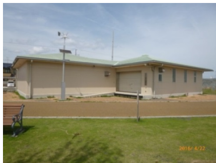
防災倉庫(静岡県焼津市 石津西公園)
