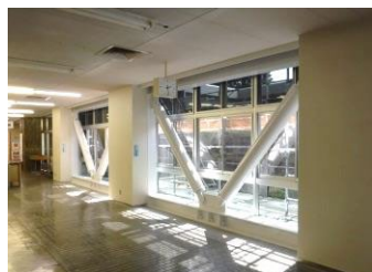
市役所の耐震改修 (岐阜県中津川市)
