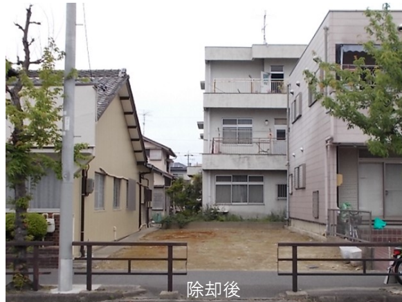
不良住宅の除却 (愛知県一宮市)
