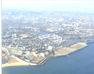
三重県南部浄化センター
