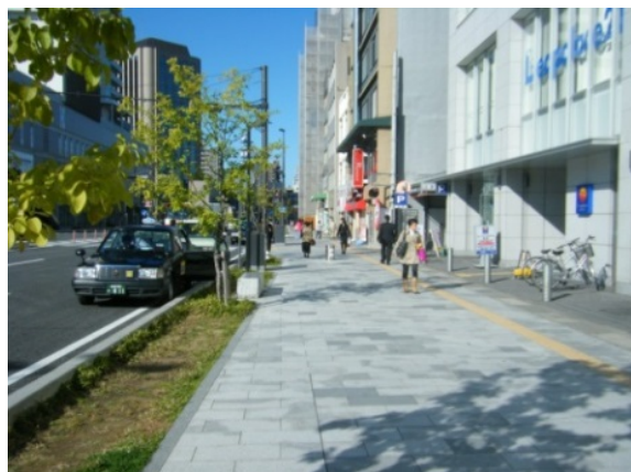
岐阜駅城田寺線(岐阜県岐阜市)
