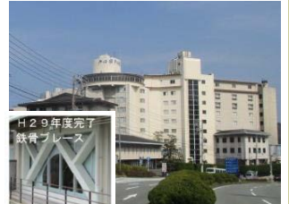
耐震改修事業 (三重県鳥羽市)
