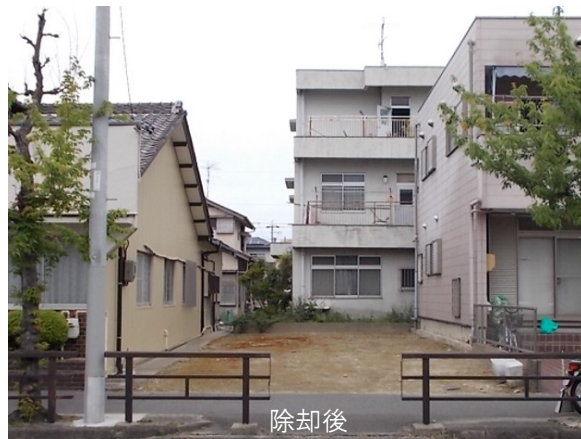
不良住宅の除却 (愛知県一宮市)
