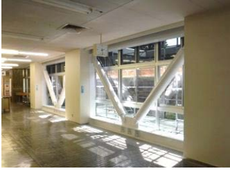
市役所の耐震改修 (岐阜県中津川市)
