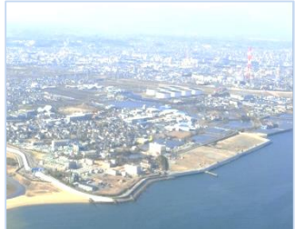
三重県南部浄化センター
