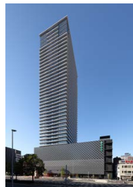
栄一丁目6番地区 優良建築物等整備事業 （愛知県名古屋市）
