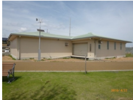
防災倉庫(静岡県焼津市 石津西公園)
