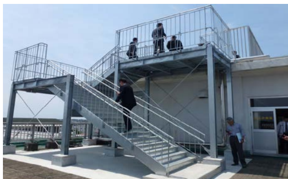
写真5.津波から命を守る避難階段の整備
