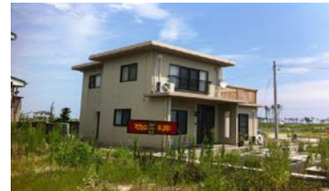
写真2.被災を受けたが早期復旧が可能であった例
