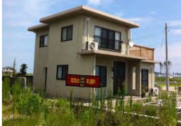
浸水したRC建物を補修し再使用している家屋
