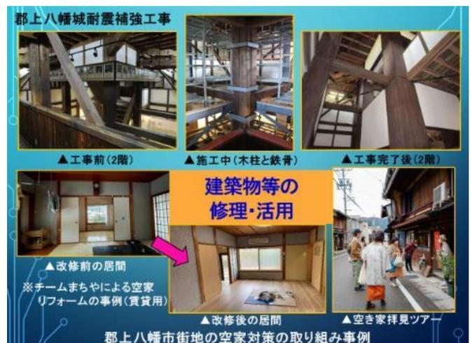
実施してきた。昨年、再建 90 年を迎えるにあたり、耐震補強を行い、内部の既存の柱に鉄骨を覆って、さらに木板で囲むなどの工夫を行ったが、従来の外観を損なわないように配慮した。
