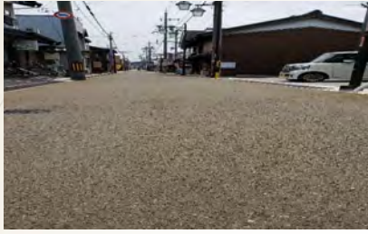
市道農人町八幡町線(施工前)
