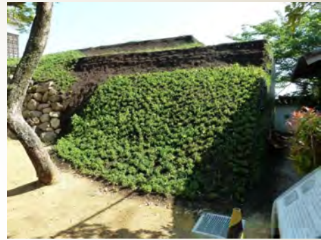
平成23年6月 土居として復旧復原
