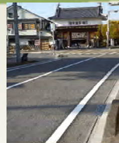
掛川城周辺道路美装化箇所
