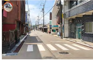
市道農人町八幡町線(施工後)
