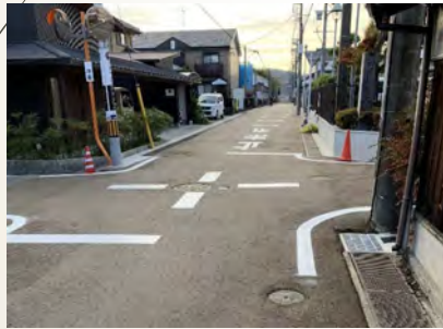
市道小田西明寺線(施工前)
