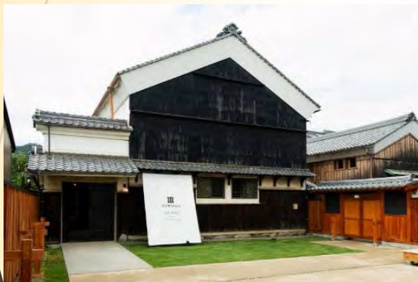
旧松久邸外観（改修後）
