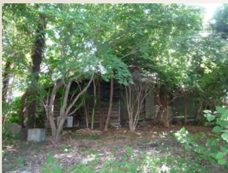
加藤家主屋 修理前
