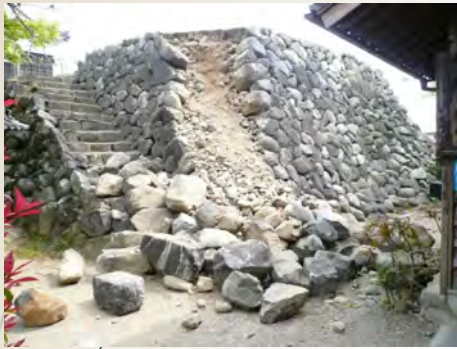
平成19年4月 地震により崩落した石垣
