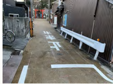
市道小田西明寺線(施工後)
