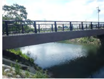
神宮橋整備状況
