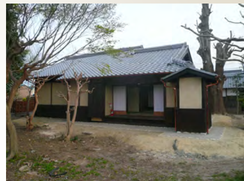
修理後(平成25年度)
