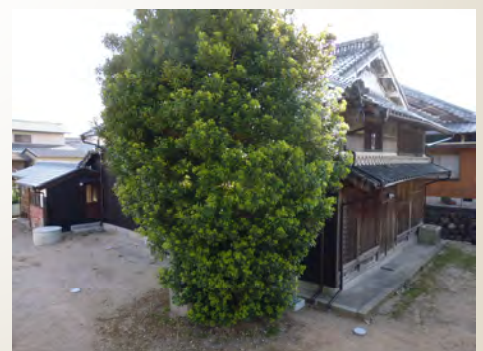
修理後(平成27年度)
