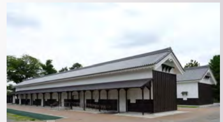
重要文化財等展示収蔵施設 「西の丸御蔵城宝館」
