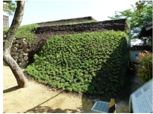
平成23年6月 土居として復旧復原
