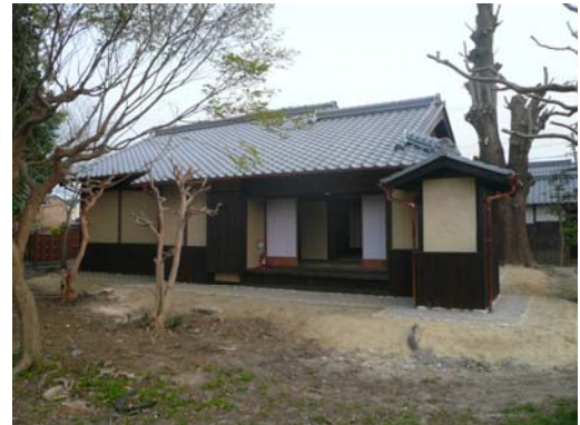
修理後(平成25年度)
