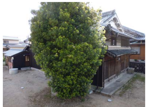
修理後(平成27年度)
