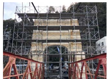
主塔耐震補強等
