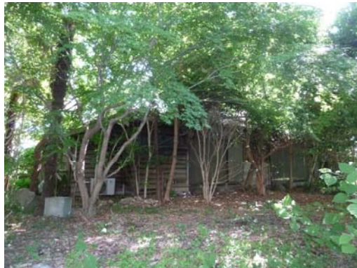
加藤家主屋 修理前
