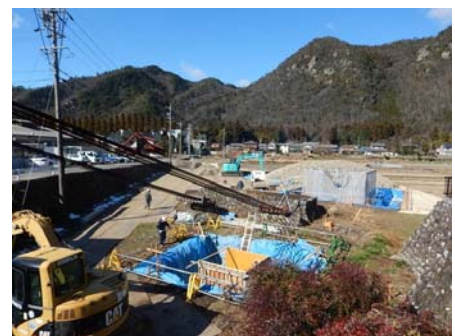
右岸アンカー補強
