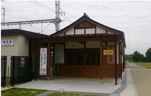
近鉄斎宮駅史跡公園口整備状況
