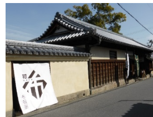
(例)歴史的建造物の修理・買取
