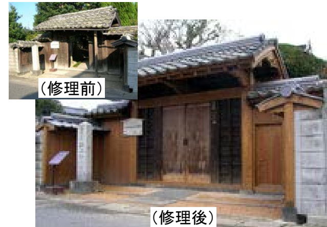
ワンコイントラストで修理が実現した 井上勝邸旧門
