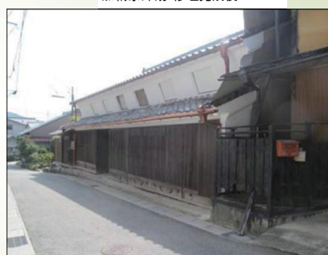
加納家外観・修理完成後
