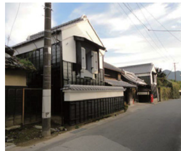
修理・復元整備後
