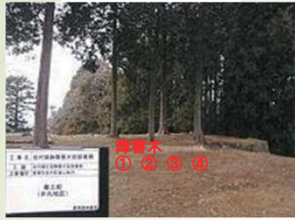
障害木伐採施行前
