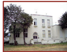
旧三島測候所庁舎
