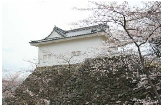
石垣の復旧・復原工事完了後、多門櫓 (建造物)の復原修理を実施した(平成 23~24年度)。建造物修理完了後、三 重県有形文化財(建造物)、及び亀山
