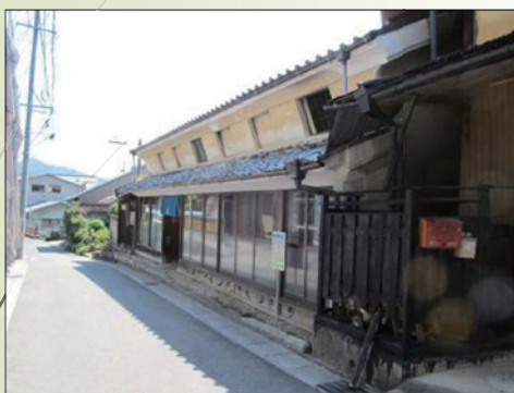
加納家外観・修理前
