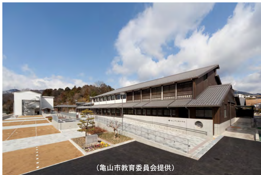
亀山市立関中学校校舎改築事業(新校舎)
