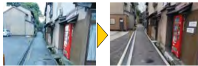
整備前 整備後
