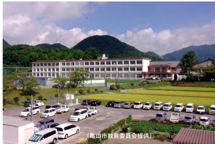
亀山市立関中学校校舎改築事業(旧校舎)
