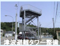
津波避難タワー整備
