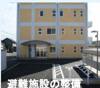
避難施設の整備
