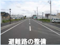
避難路の整備
