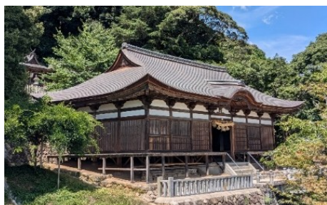
保存修理を終えた春日神社拝殿 （県指定有形文化財）
