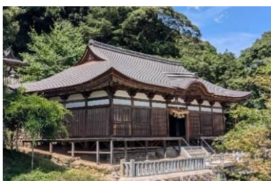
保存修理を終えた春日神社拝殿（県指定有形文化財）
