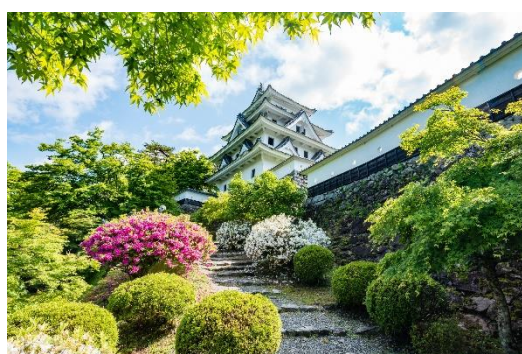
耐震補強工事を終えた郡上八幡城
