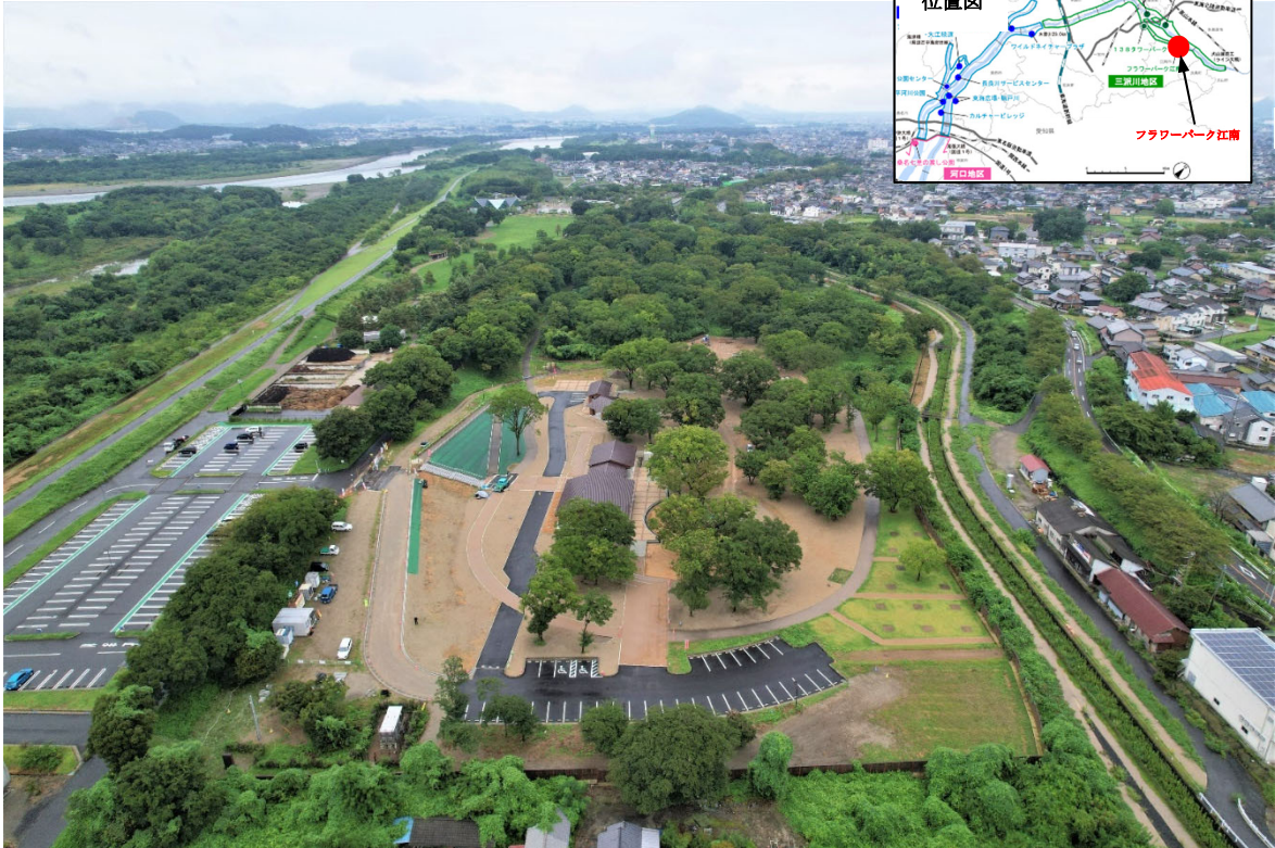
Ⅱ期地区(約 9.5ha)全景
