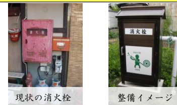
現状の消火栓
