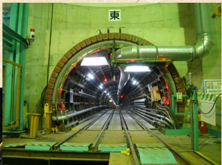
立坑付近坑口
