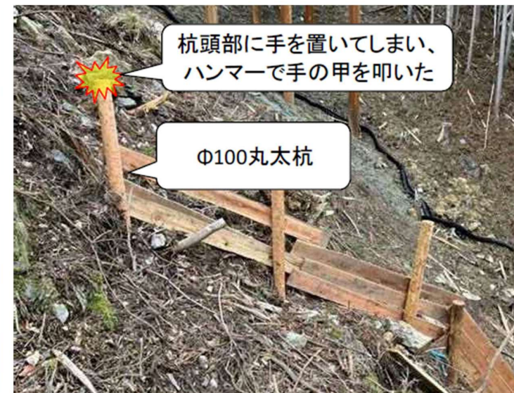
現地の状況写真
