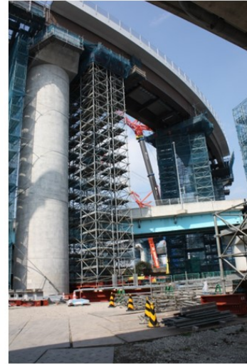
【参考】昇降設備と幅木付作業床を内蔵した折り畳み式ベント
