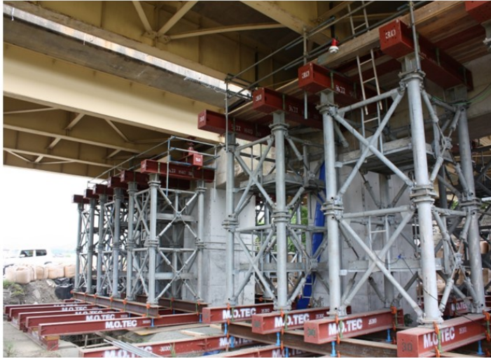
【参考】昇降設備と幅木付作業床を内蔵した折り畳み式ベント
