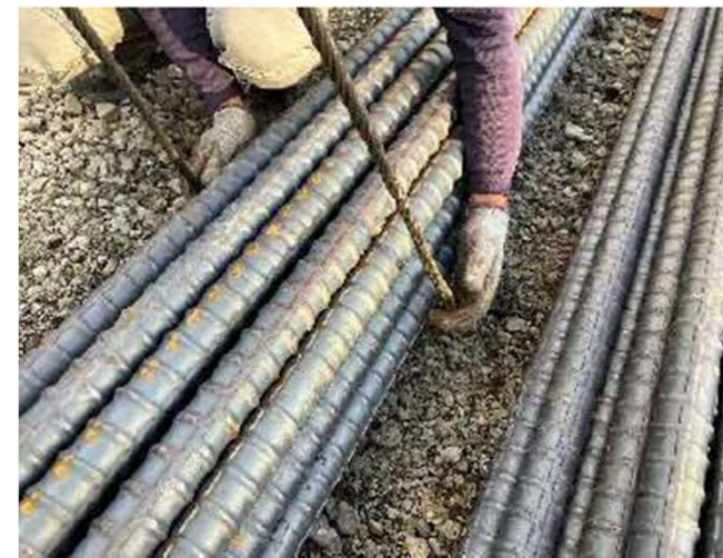
被災状況の再現写真
