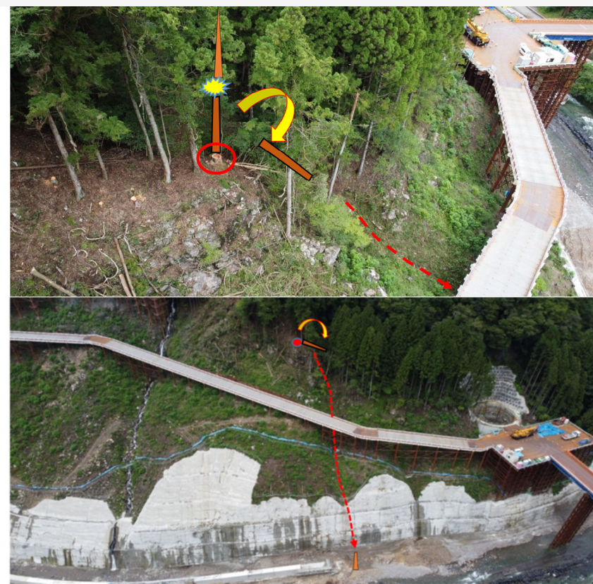
施工狀況写真
