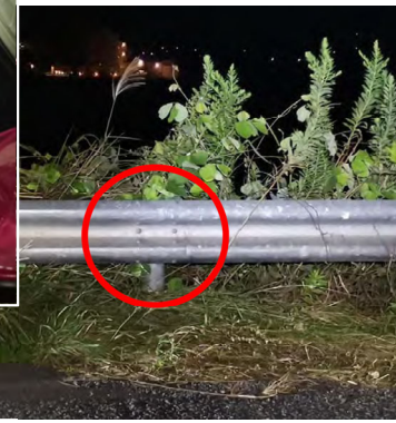
ガードレール損傷部
