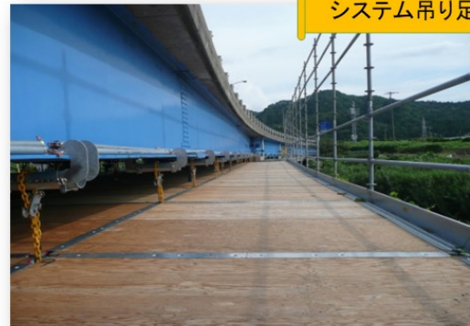
システム吊り足場
