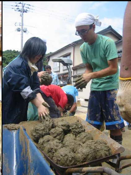
泥団子を作って現場へ運び込み 竹小舞目掛けてカー杯「手打ち」
