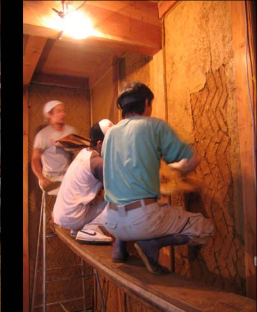
泥団子を作って現場へ運び込み 竹小舞目掛けてカー杯「手打ち」
