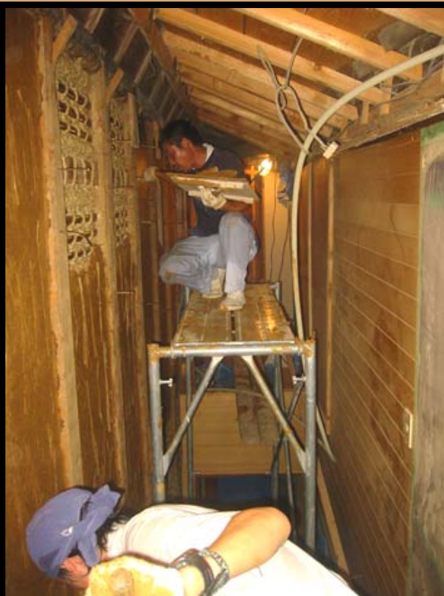
混ぜ合わせたままの土を 現場にバケツリレーで運搬 左官職人5人で塗り付け
