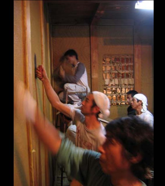
泥団子を作って現場へ運び込み 竹小舞目掛けてカー杯「手打ち」
