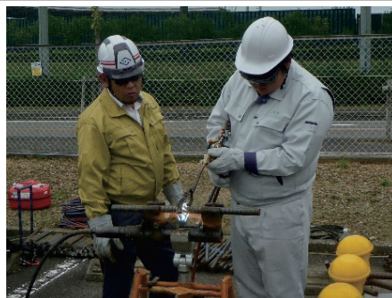
↑鉄筋のガス圧接の体験実習
