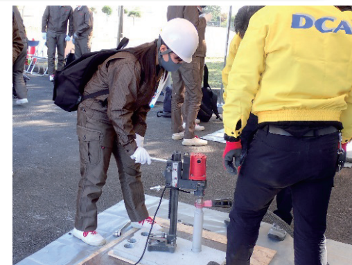
▲コンクリート板の穴あけ体験実習
