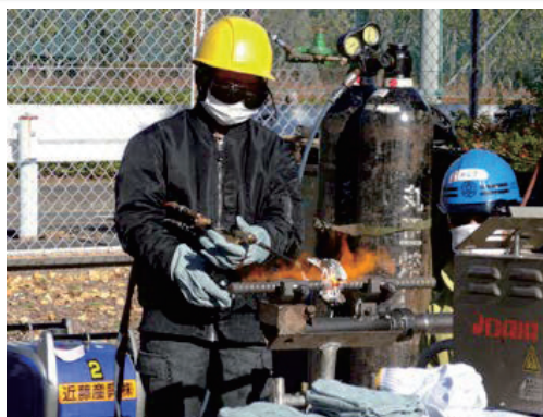
▲鉄筋ガス圧接の体験実習
