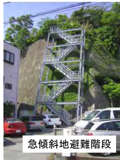
急傾斜地避難階段
