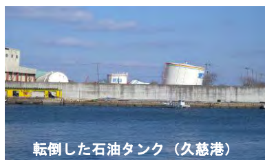
◇石油タンクの損傷等による火災等
