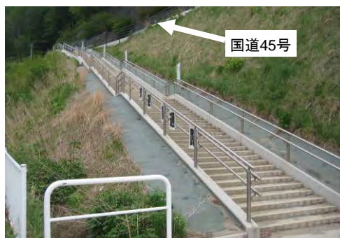
◇津波避難階段（岩手県岩泉市）
