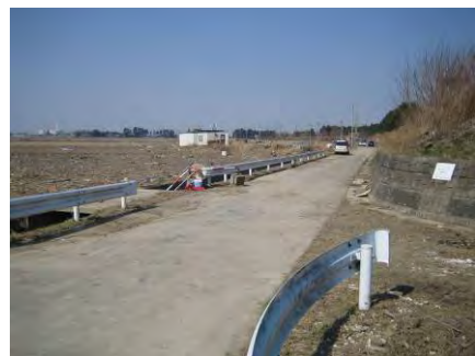
◇仙台東部道路より陸側 (西側)
