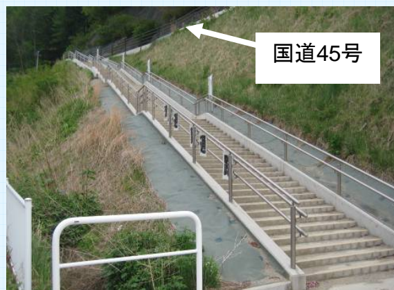
◇津波避難階段 （岩手県岩泉市）
