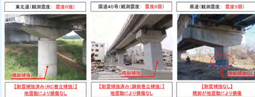
◇橋脚耐震補強（東北道、国道45号）
