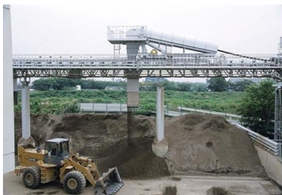
(参考)写真 12 鳴海改良土センター(名古屋市) 出典：名古屋市
