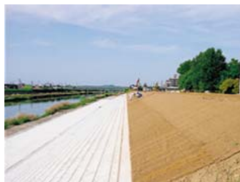
（参考）写真 4 堤防の強化状況（名古屋市西区）
