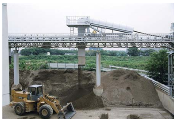
(参考) 写真7 鳴海改良土センター(名古屋市) 出典：名古屋市
