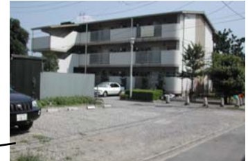
整備されたコミュニティ住宅
