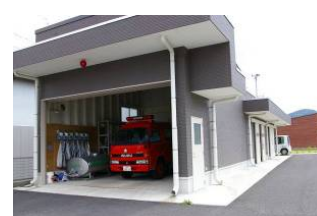
※防災備蓄品や消防自動車を保管 (三重県度会町)
