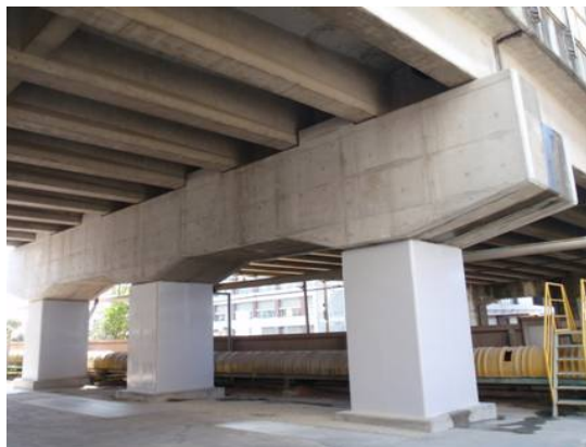
(都)田子浦伝法線JR跨線橋耐震化 (静岡県富士市)
