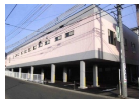
尾鷲総合病院透析センター (三重県尾鷲市)
