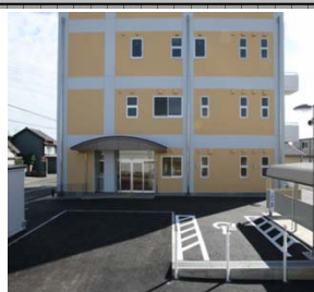
小川第13自治会コミュ ニティ防災センター (静岡県焼津市)
