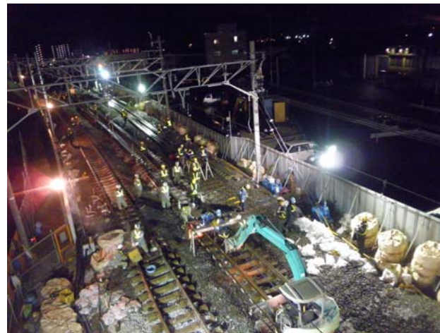
【線路切替作業状況②】
