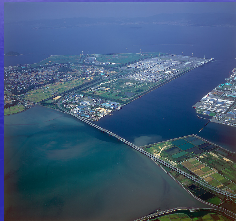
三河港大橋方面から田原臨海部を望む
