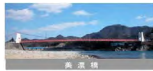
重要文化財美濃橋保存修理事業
