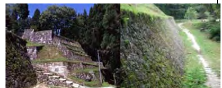
岩村城石垣修理事業
