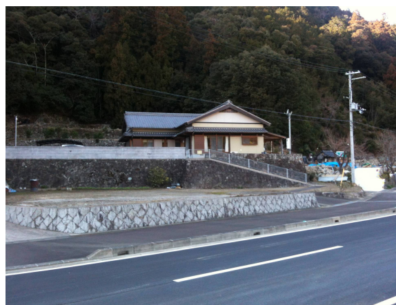
山の斜面を利用した地盤の嵩上げ
