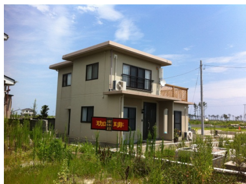
浸水したRC建物を補修し再使用している家屋 (東日本大震災の被災地)
