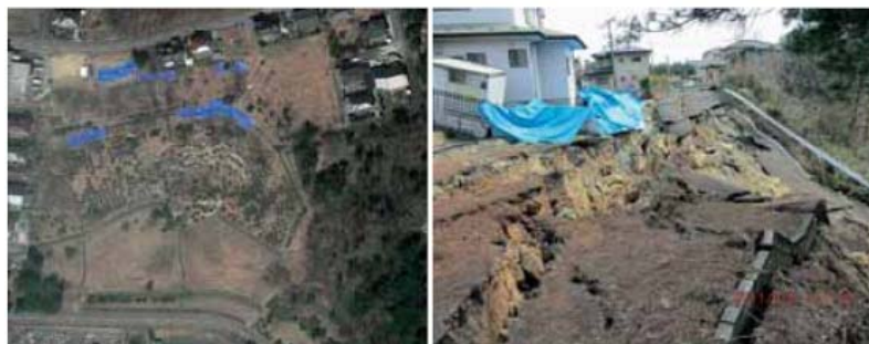
パターンb)の被災状況
