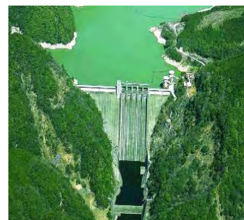
佐久間ダム（昭和31年完成）
