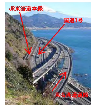
地すべりと併走する重要交通施設
