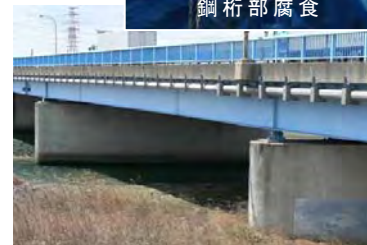
国道 23 号 町屋大橋 （三重県桑名市）
