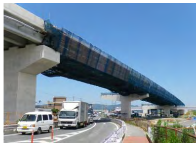
国道 23 号名豊道路（豊橋バイパス） 前芝高架橋（仮称）の状況
