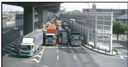
遮音壁設置例（愛知県名古屋市）
