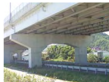
国道 1 号 白須賀高架橋 （静岡県湖西市）
