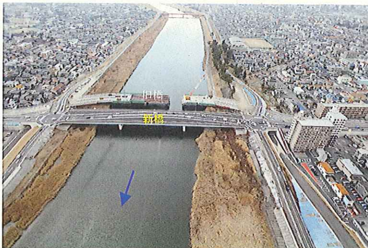
一色大橋 架替部（平成23年度完成予定）
