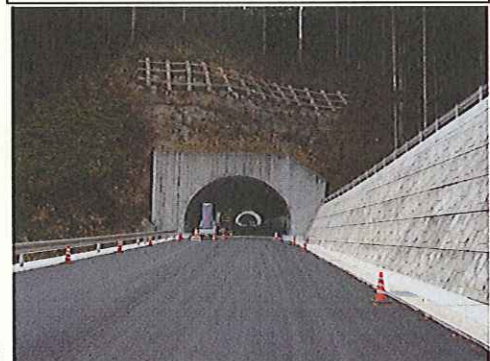
愛知県新城市名号～浜松市北区引佐町 間 笑島トンネル付近工事状況
