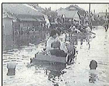
伊勢湾台風による浸水状況
