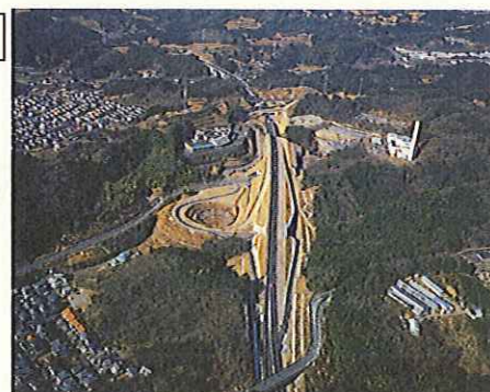
三島加茂 IC 付近工事状況
