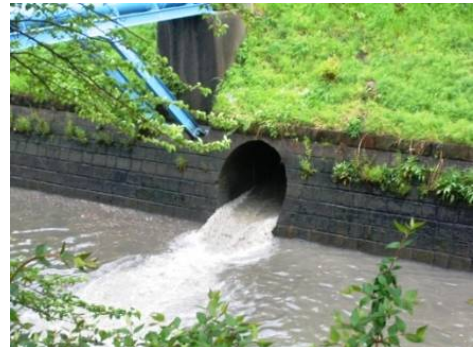
(参考)図 14 合流式下水道の現状 資料：名古屋市
