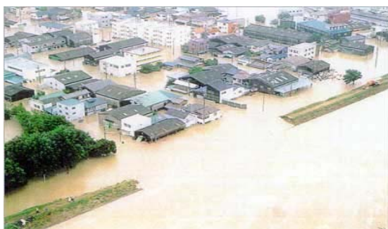
(参考)写真1 新川の破堤状況(西枇杷島町)
