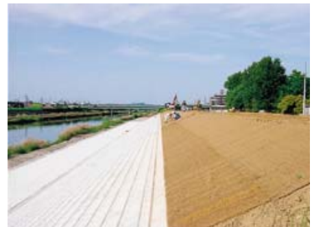
(参考)写真 3 堤防の強化状況（名古屋市西区）
