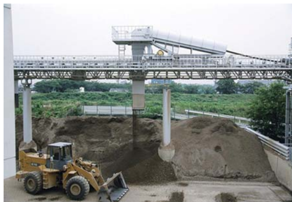
(参考) 図 32 鳴海改良土センター(名古屋市) 出典：名古屋市
