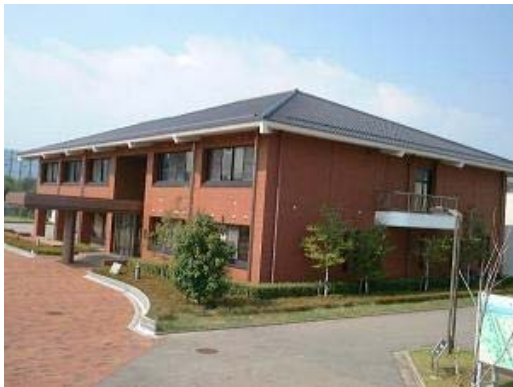
(参考) 写真 9 焼却灰入りの外壁タイル、瓦を利用した衣浦東部浄化センター管理本館
