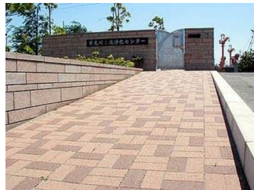
(参考) 写真 10 下水汚泥焼却灰を混ぜて作った歩道用ブロック
