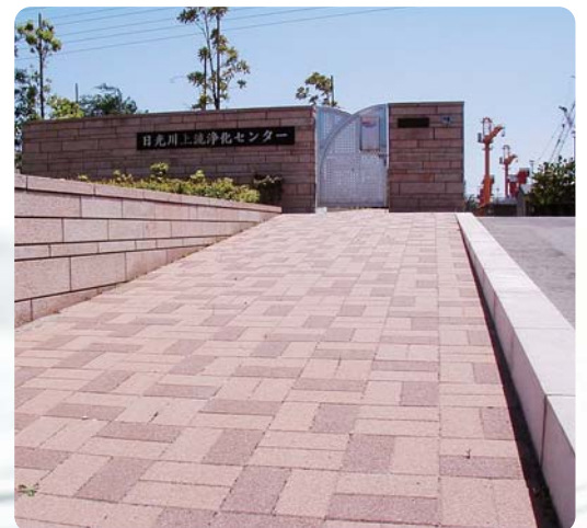
下水汚泥焼却灰を混ぜて作った歩道用ブロック
