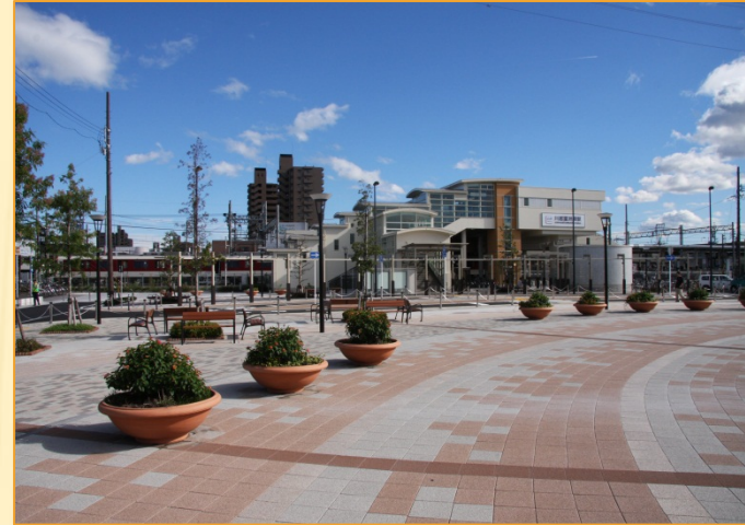
川越富洲原駅前広場
