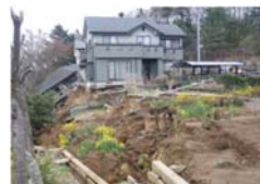
造成宅地の滑動崩落
