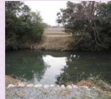
整備箇所(神宮橋跡)
