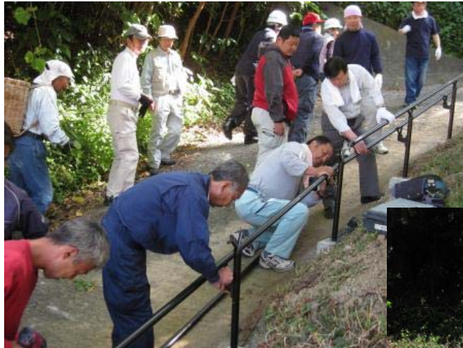
土肥小学校裏避難路
