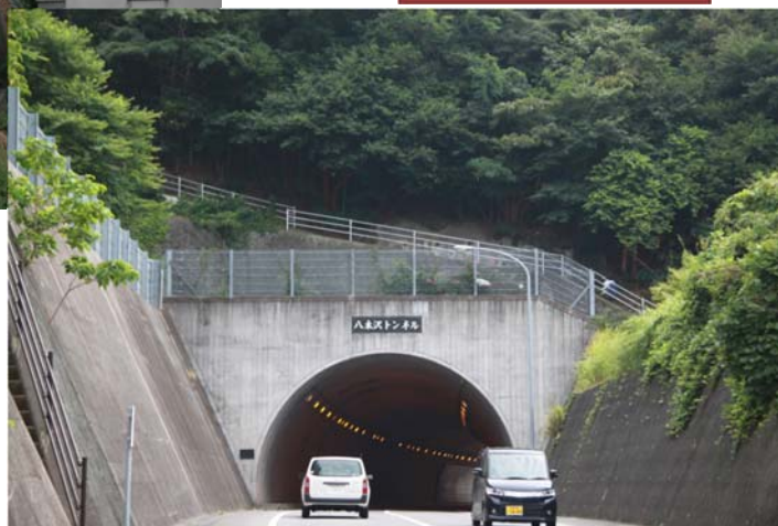
八木沢トンネル避難路 (Yamazaki Tunnel Evacuation Route)
