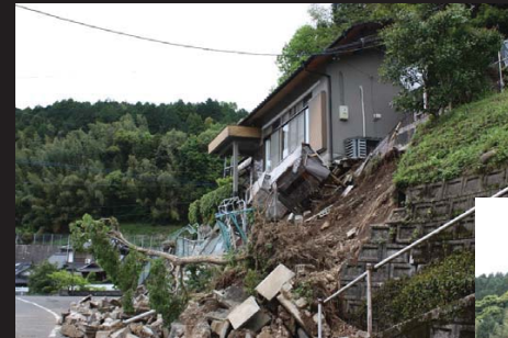
上鳥子地区 崩壊箇所
