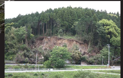
星田地区 崩落箇所
