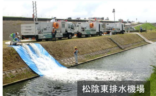
【排水作業訓練】
