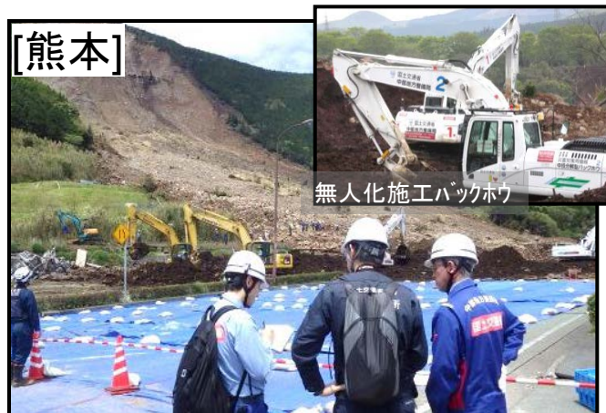
崩落現場の点検作業(阿蘇大橋付近)
