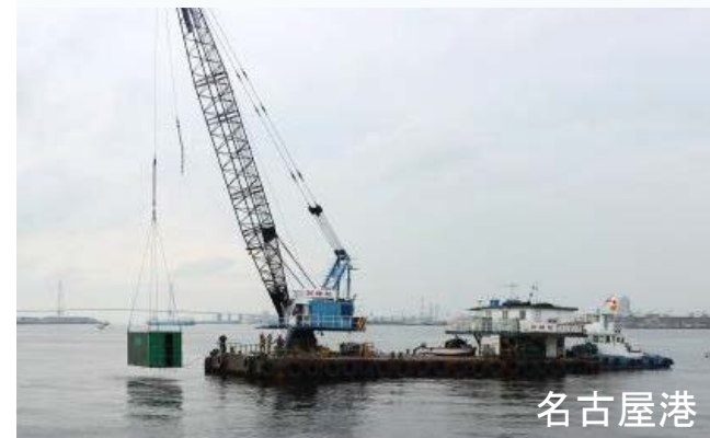
【航路啓開】 (航路内に沈んだコンテナの揚収)
