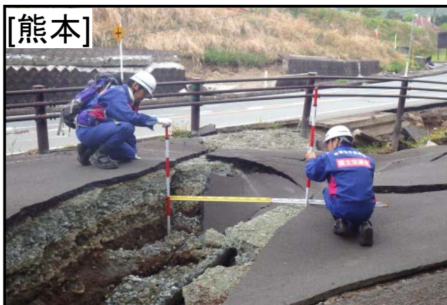
熊本県道28号大切畑大橋の被災調査(西原村)
