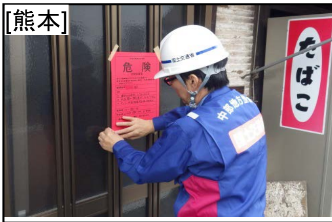
民家の建築物危険度判定調査作業(熊本市)
